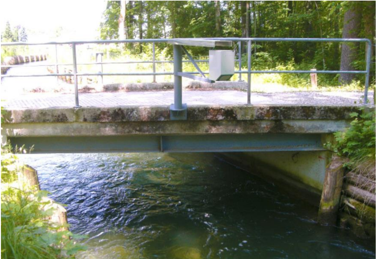
Σχήμα: Ραντάρ SOMMER RQ-30 εγκατεστημένο σε γέφυρα (SOMMER, 2018)
